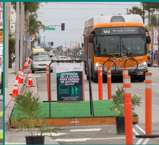
**3** La extensión de la acera para autobuses alinea la parada de autobús con la vía de estacionamiento disminuyendo la cantidad de tiempo perdido al entrar y salir del tráfico y a la vez mejora la eficiencia de embarque.
